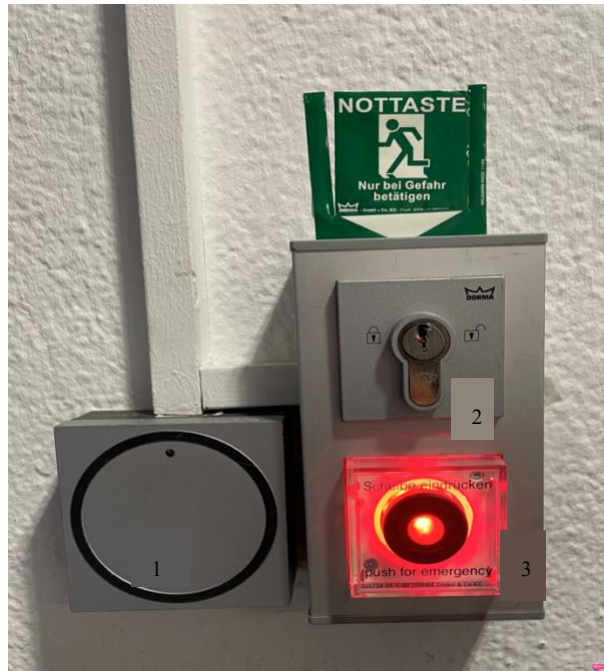
Abb. 2: Schließmechanismus der Station (1 - Transponder-Schließanlage; 2 - Schlüssel-Schließanlage; 3 – Notfallknopf)
