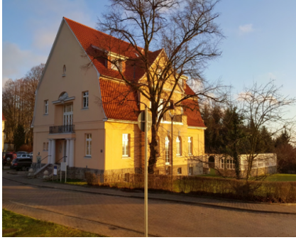
Abbildung 11 b: Blick von Südwest: Das ehemalige Direktorenhaus der Anstalt Pfafferoode bei Mühlhausen in heutigem Zustand (2016)
