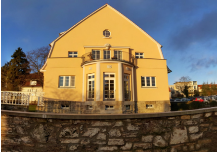
Abbildung 11 e: Blick von Ost: Das ehemalige Direktorenhaus der Anstalt Pfafferoode bei Mühlhausen in heutigem Zustand (2016)
