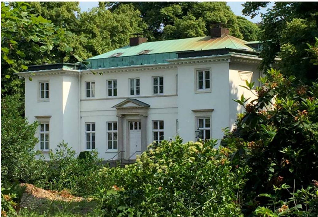
Abb. 66: Landhaus Pierre Godeffroy (Weißes Haus), Architekt: C. F. Hansen, Ansicht 2018
