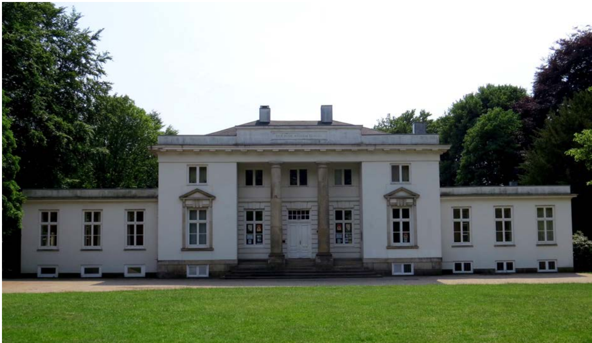
Abb. 63: Landhaus J. C. Godeffroy (Hirschparkhaus), Architekt: C. F. Hansen, Ansicht 2018
