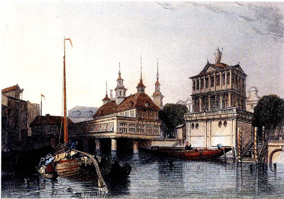
Abb. 17: Ansicht der Börse von der Wasserseite nach der Aufstockung des Gebäudes
