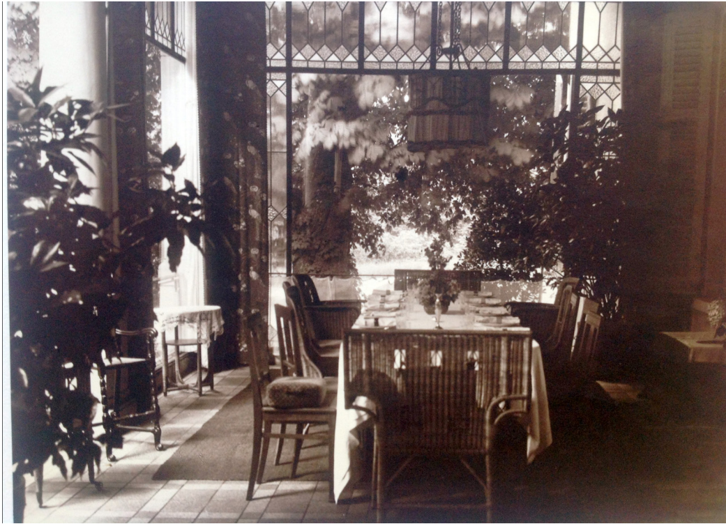
Abbildung 9.19 Wintergarten / Außen Terrasse
