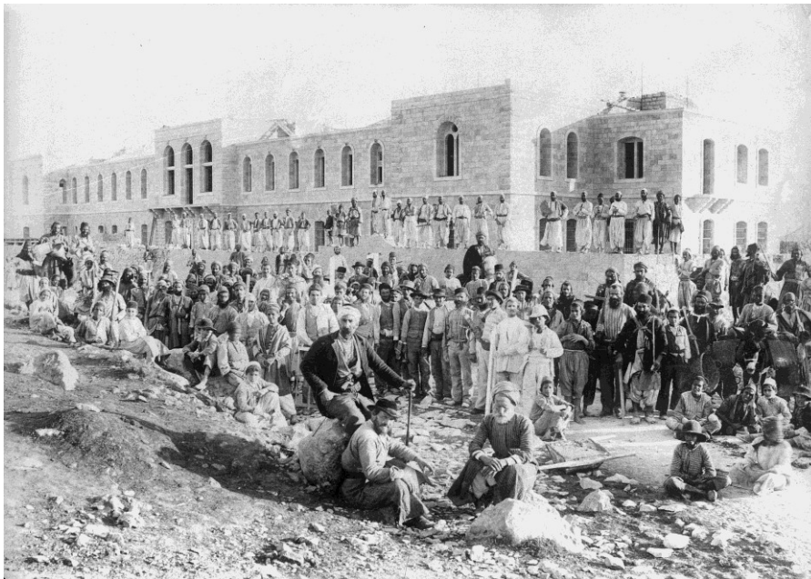
Abb. 12 Das Schaare Zedek Krankenhaus während der Bauarbeiten. SZMC Jerusalem.
