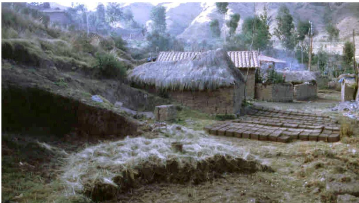
Abb. 3.12: Herstellung der Baumaterialien für den Häuserbau
