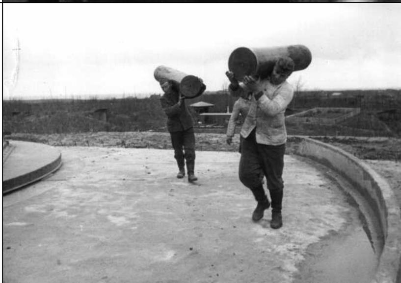
Abgeschossene Kartuschen 28-cm SK L/45 werden zum Wiederladen vom Geschützturm weggetragen. Die Kartuschen wurden mehrmals verwendet und nach dem Abschluß gereinigt sowie mit einer neuen Ladung versehen.
