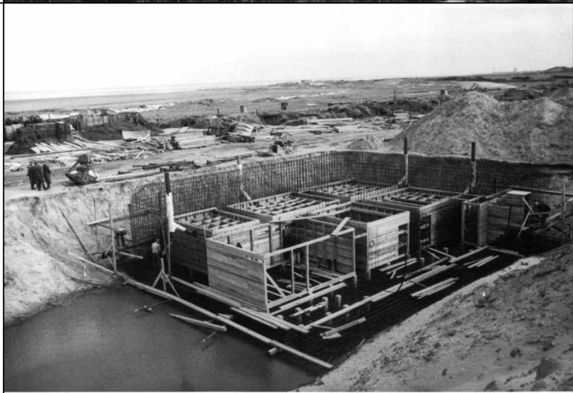
gegen die Verschalung; später hatten wir dafür Maschinen. Unsere Verschalung bestand aus Paletten, die aus 2 x 5 Zollbalken und 4/5 Zollbrettern gezimmert waren. Die Paletten waren 1 m breit und 1 bis 2 m hoch. Vor dem Schütten wurden sie mit Balken verschiedener Dicke abgesteift, und die Wände wurden mit Beschlägen, den sog. Kartoffeln, zusammengehalten.
