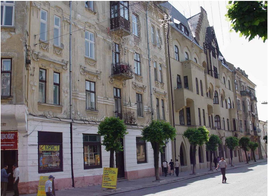
Czernowitz, ehemalige Herrengasse mit ehem. Deutschem Haus (zweites Gebäude). Foto 2005.
