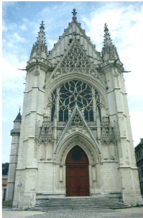
Abb. 56 Vincennes, Sainte-Chapelle, Ansicht von Westen
