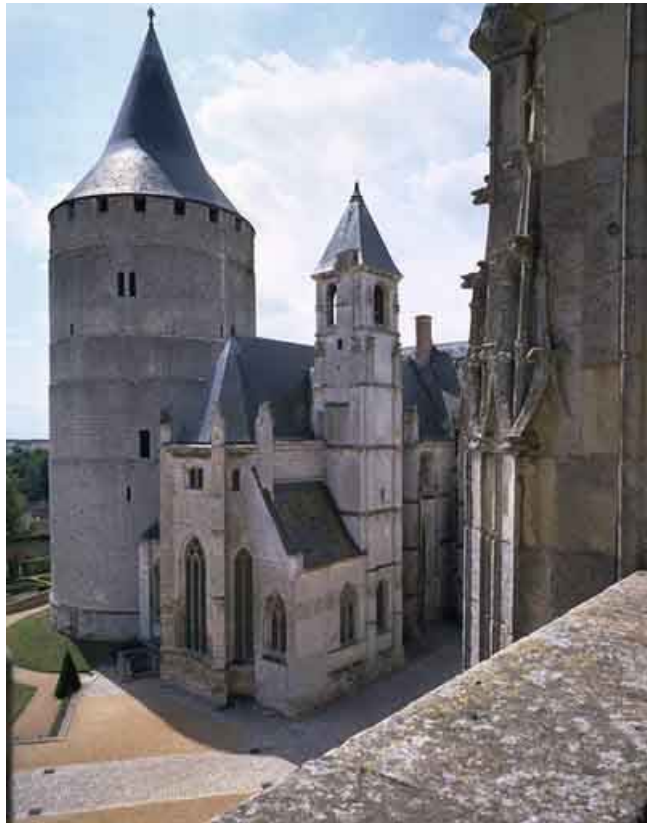
Abb. 70 Châteaudun, Sainte-Chapelle von Nordosten
