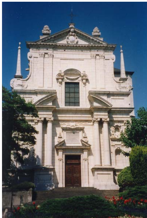
Abb. 50 Chambéry, Schloßkapelle, Fassade
