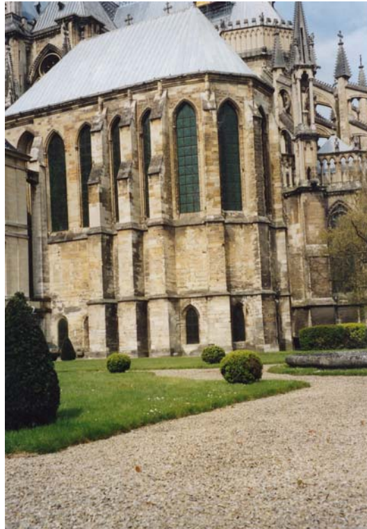
Abb. 36 Reims, erzbischöfliche Kapelle, Ansicht von Südosten
