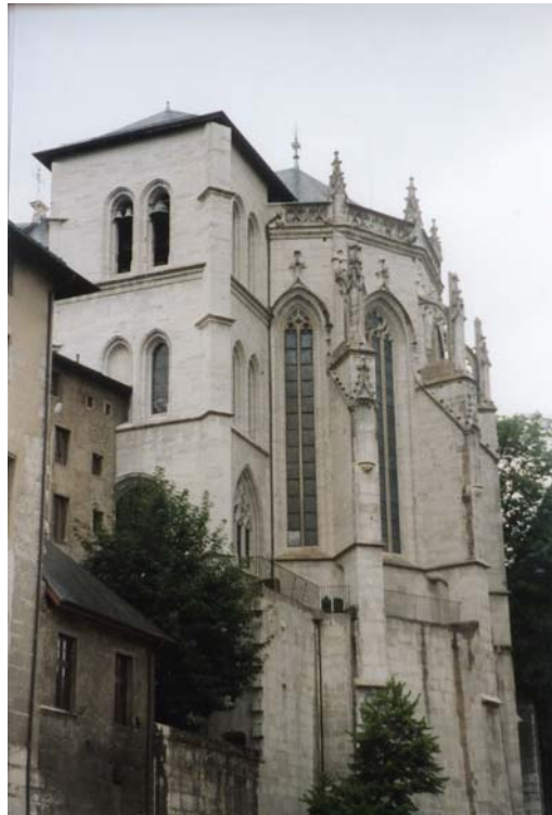
Abb. 49 Chambéry, Schloßkapelle, Chor und Glockenturm
