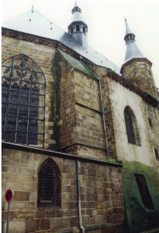
Abb. 84 Vic-le-Comte, Sainte-Chapelle, Ansicht von Nordosten
