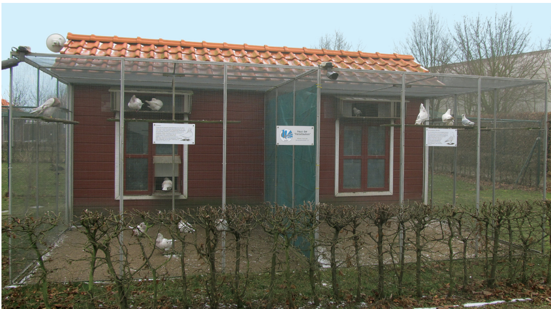
Abbildung 19: Außenansicht Stallgebäude mit angrenzenden Außenvolieren
